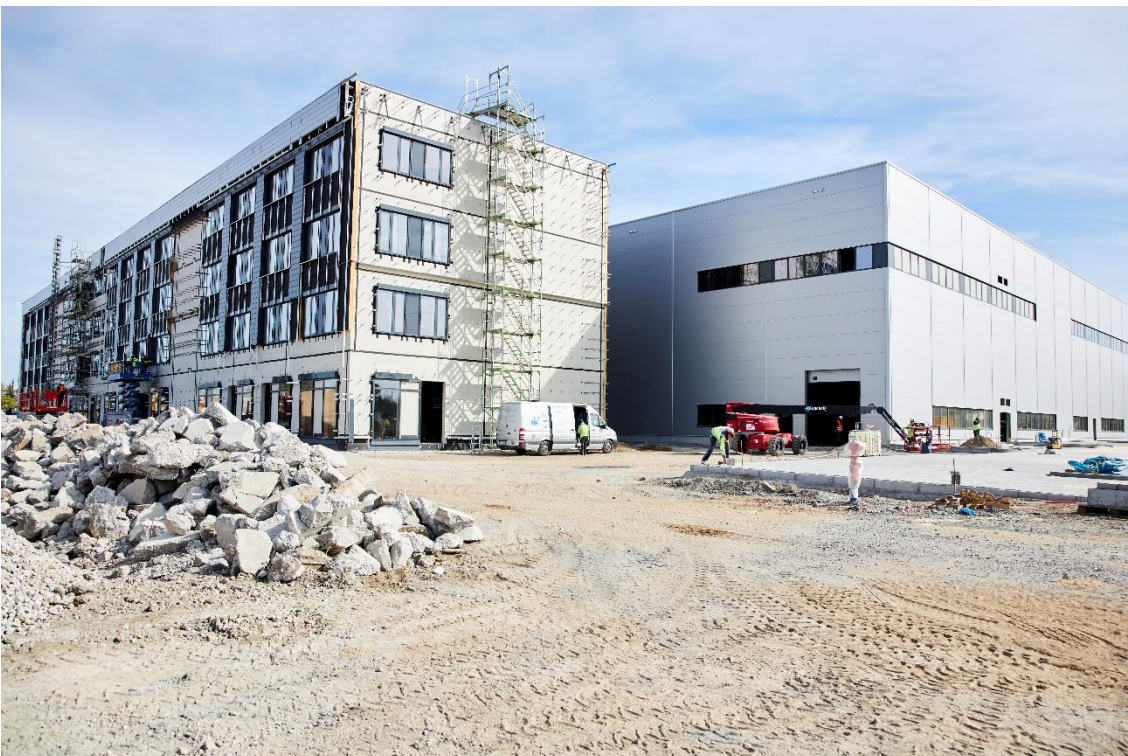
Planmäßiger Baufortschritt: AKASOLs neues Headquarter inclusive Gigafactory 1 im Südwesten Darmstadts steht kurz vor der Fertigstellung und ist ein wichtiger Baustein für das nachhaltige dynamische Wachstum.
